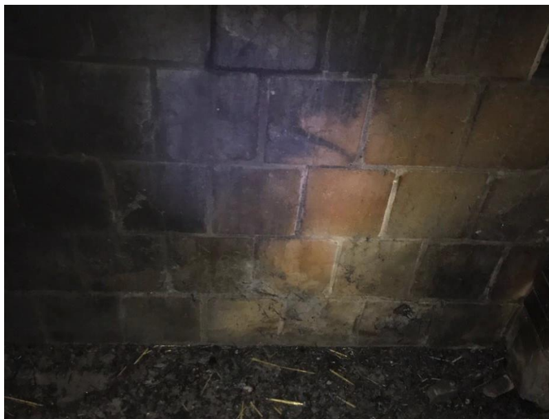
Foto 03: Indvendig brandisolering ved kælderydervægge
