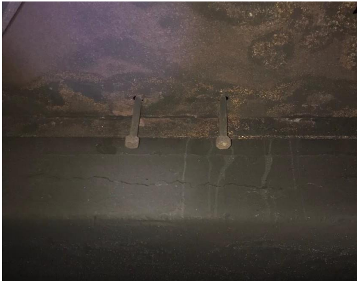
Foto 06: Laminering i dæk over kælder.
