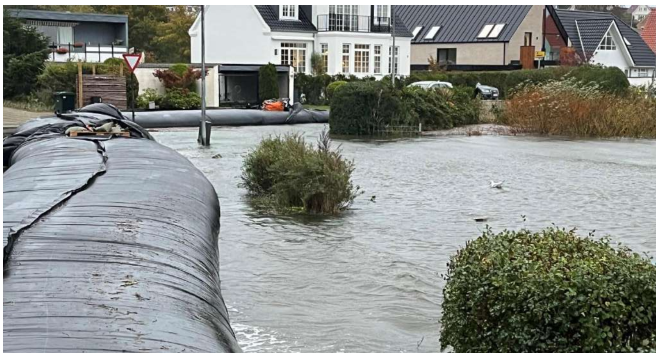
Billede: Water-Tube ved Fjordvej i Kolding
