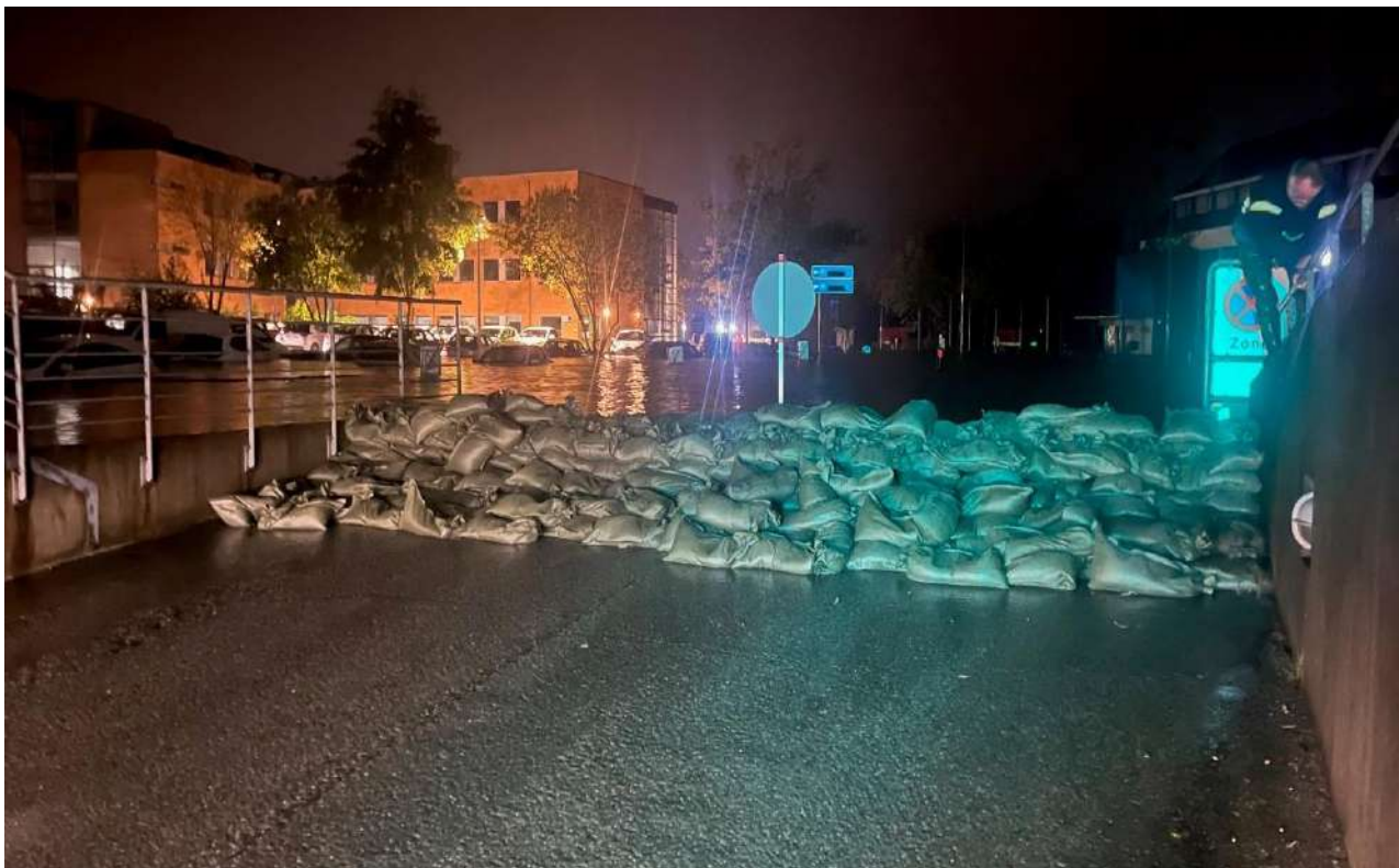
Billede: Opdæmning ved P-kælder til IT og stadsarkiv i Kolding
